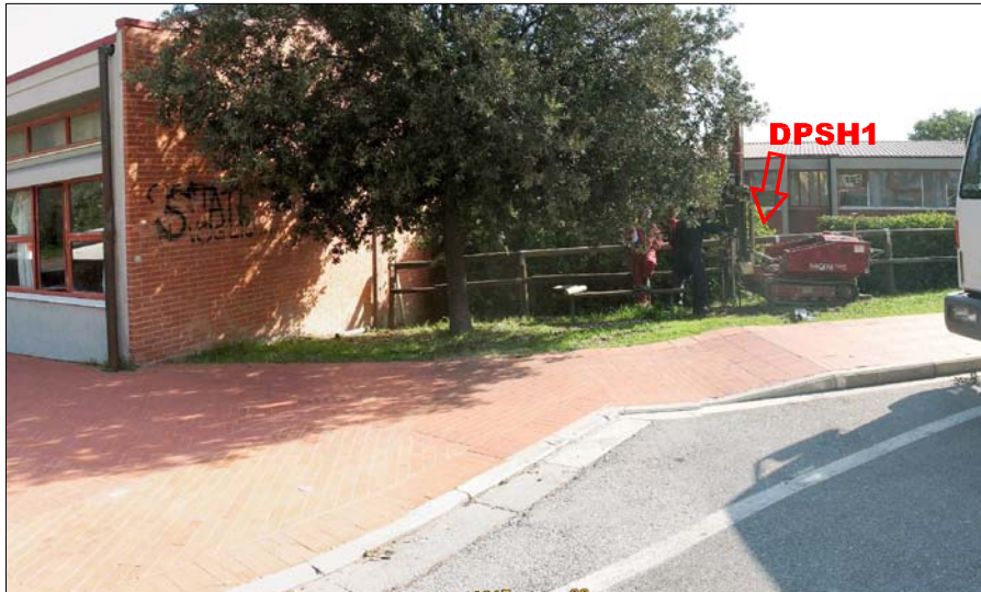
Foto n. 5: esecuzione della prova penetrometrica DPSH1.
