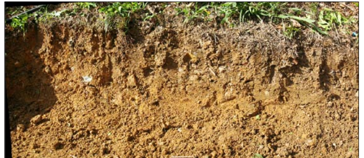
Foto n. 7: presenza di terreni di riporto alla base della scarpata oggetto di intervento.
