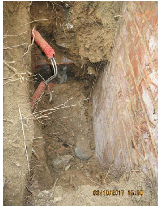
Foto n. 11: saggio S1, profondità 1 m, riporto sabbioso con macerie.
