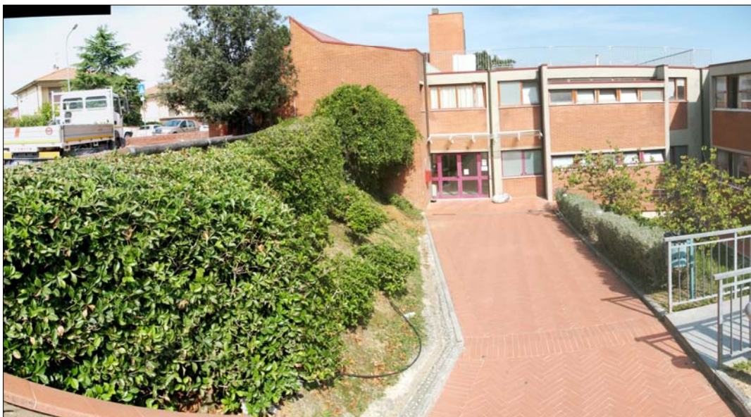
Foto n. 1: panoramica dell'area di intervento.
